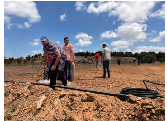
配付した灌漑パイプを設置している様子
