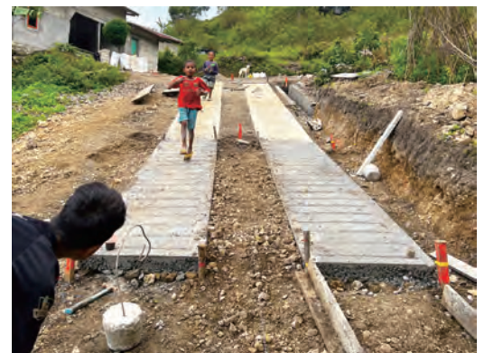
急斜面に敷設されたコンクリート道路
