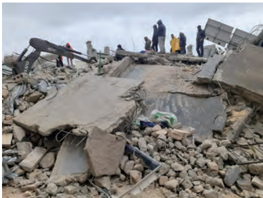
シリア北部の倒壊した建物
