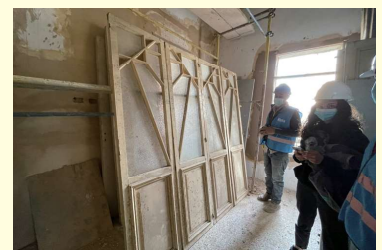
補修した扉を見せてくれるオクラさん(写真奥)
