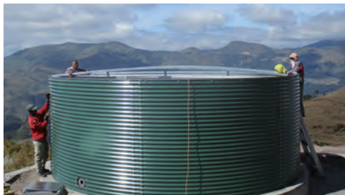
60m 3 の水タンクを設置
