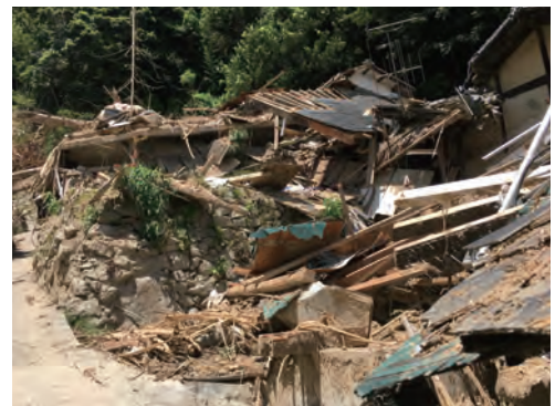
大雨で倒壊した家屋
