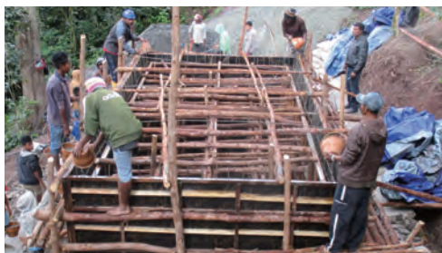
揚水ポンプ内臓タンクへのコンクリート流し込み
