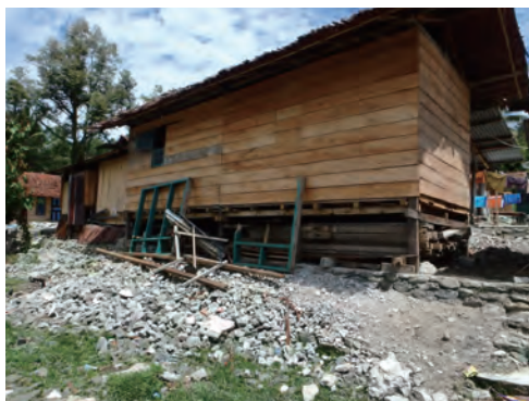
再建された伝統家屋による仮設住宅
