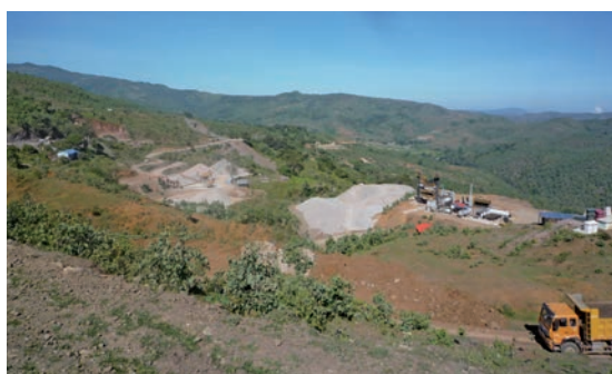
国道整備の様子
