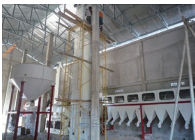
コーヒー二次加工場の機械設置風景
