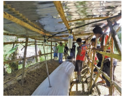
バイオガス・プラントの設置の様子
