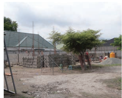
建設が進むコーヒー豆の二次加工工場
