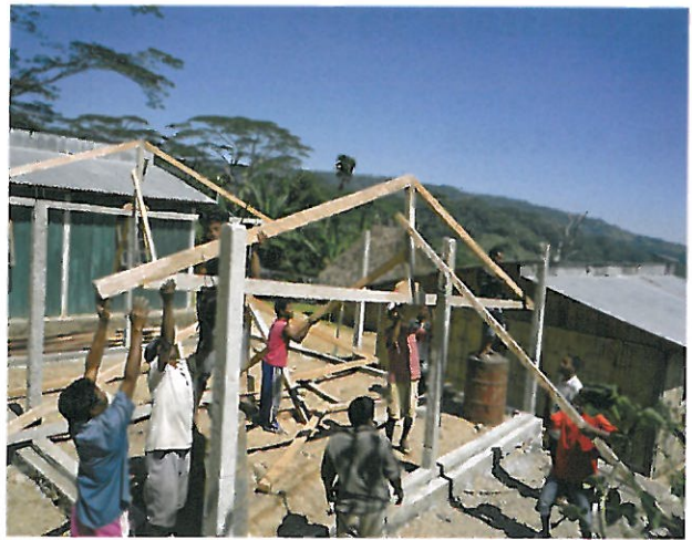
サココでの新倉庫建設(2011年6月)
