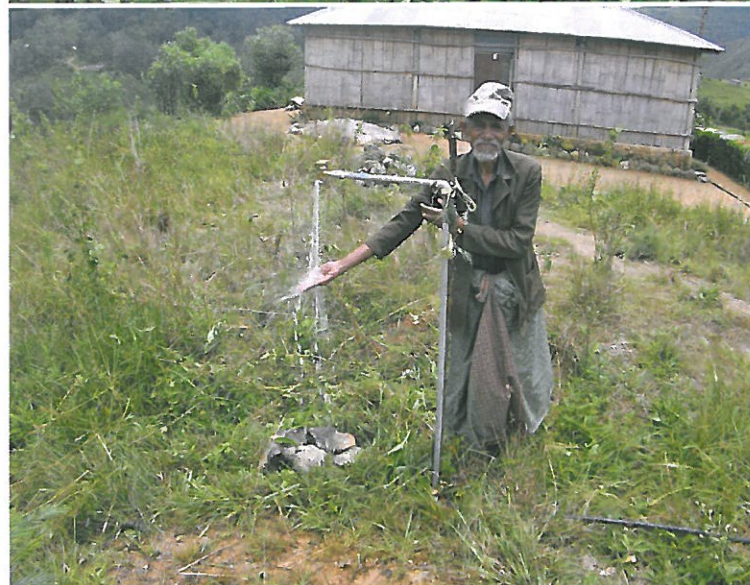
上：貯水タンクの建設 中：ホースをひくリタ集落の人びと 下：家の近くに水が来て喜ぶ住民
