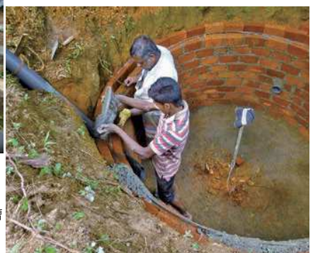
煉瓦を積み上げてバイオガスメタン発酵槽を作っていく(奥が技術者のワサンタさん、手前は手伝ってくれた村の人)
