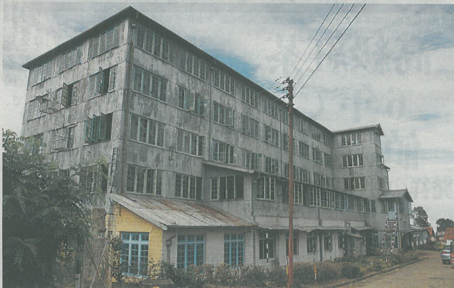
スリランカ・ヌワラエリヤ近郊にあるプランテーションの工場。古い5階建てビルで茶葉を発酵・乾燥させ、紅茶を作る。
